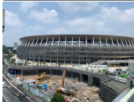
(2019/06/20) 屋根工事が終わり、最近では競技場周りの木々の植え付けなど細かい作業が目立つ印象でした。
