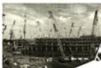
③2018年1月18日 外壁が高くなり、競技場の全体像が現れる
