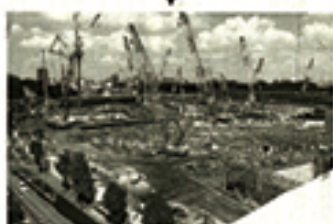
②2017年9月14日 クレーンが立ち並び、観客席も建設中
