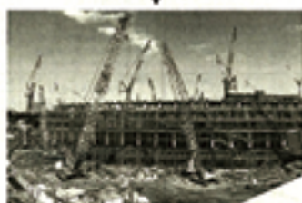
④2018年3月6日 外壁が更に高くなり、競技場の全体像が現れる
