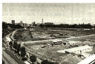
①2016年7月3日 本体工前の建設予定地
